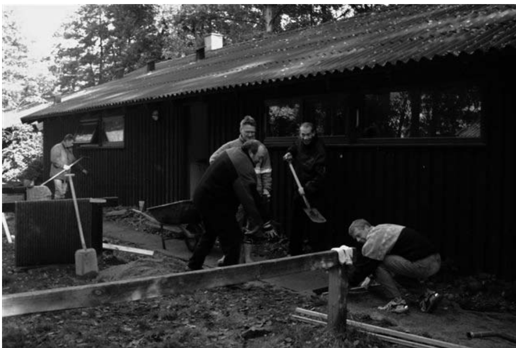
Der bliver arbejdet med flisegang foran vægtrummet
